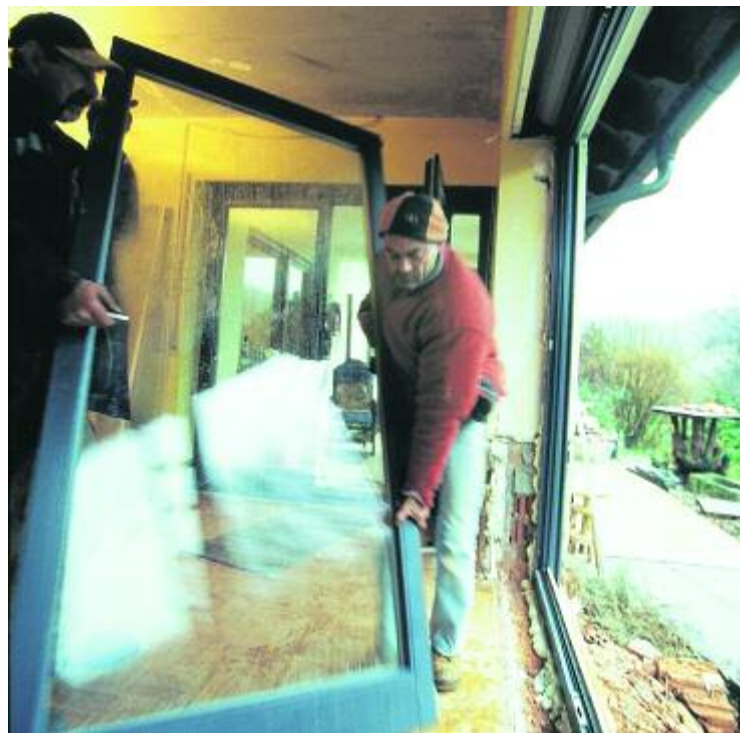
Die Erneuerung der Fenster kann zur besseren Energiebilanz des Hauses beitragen. FOTO: KFW-BILDARCHIV/THOMAS KLEWAR
